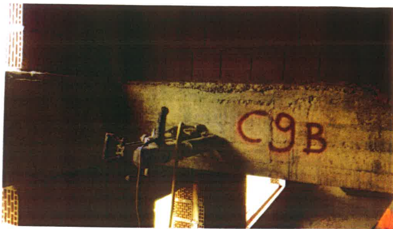
Esecuzione carotaggio trave Corpo B
